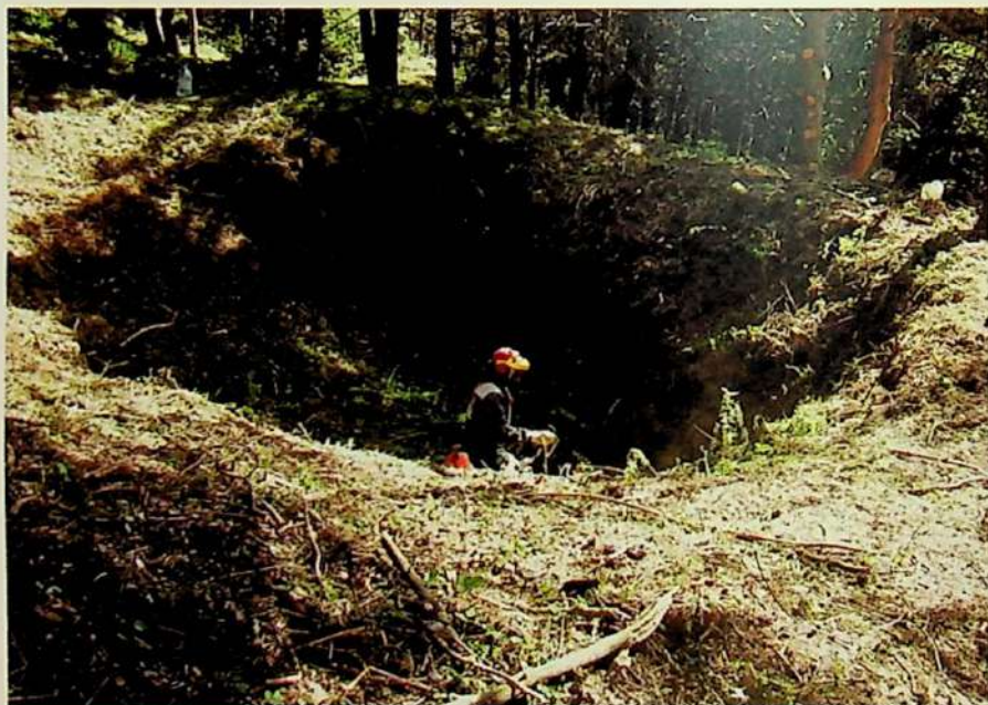
Para poder iniciar los trabajos de vaciado, había que desbrozar primero
