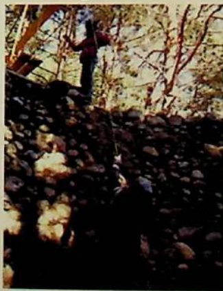
Sistema de polea manual para sacar las piedras
