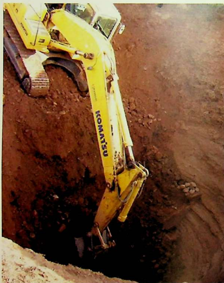
Espectacular trabajo de la excavadora en la nevera de Nalda
