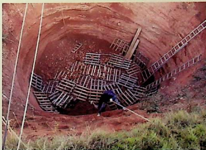
Retoque final por la empresa Trabajos Verticales
