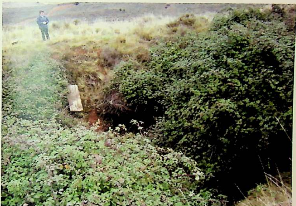
Vista de la Nevera del Cerro de la Campana antes del inicio de la intervencin
