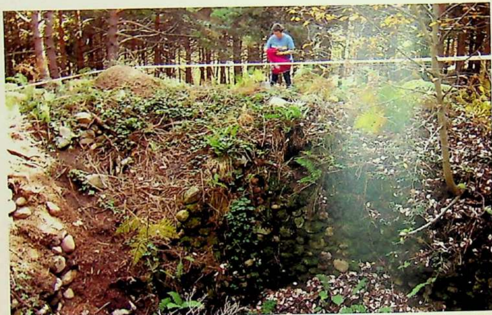
Aquí se ve perfectamente la escalera de bajada al fondo de la nevera antes de su restauración
