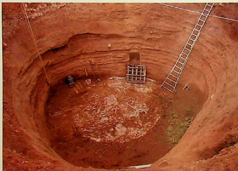
Protección del suelo mediante plásticos y una capa de tierra
