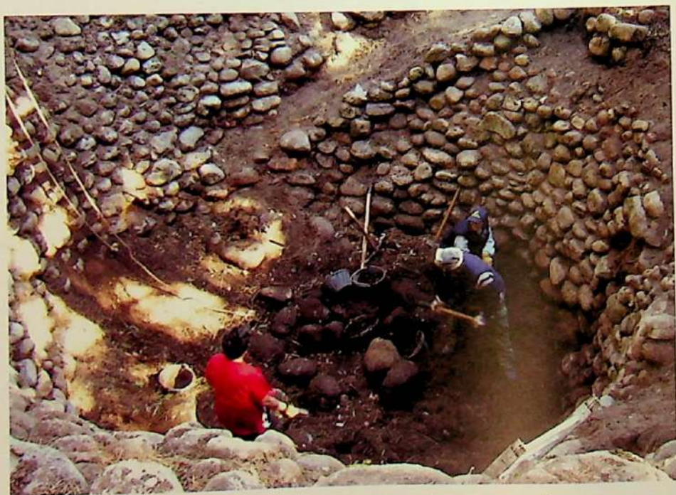
La misma bajada a mediados de su restauración
