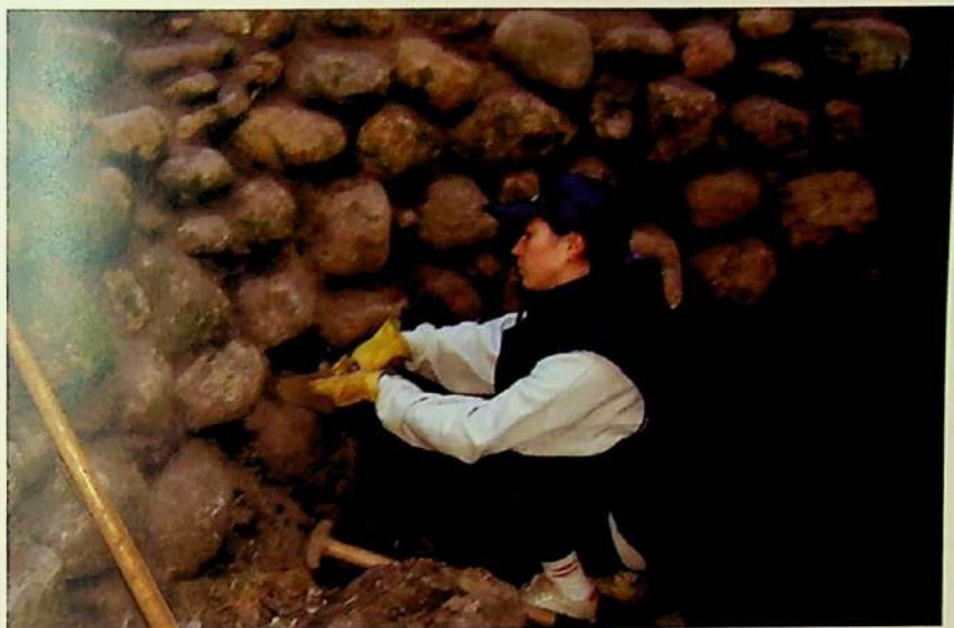
Limpieza cuidadosa de las paredes de piedra
