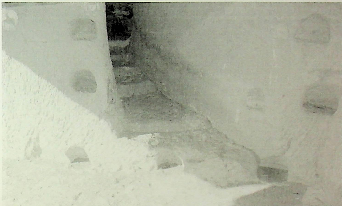
Vista de conjunto del ambiente de la lámina 10.
